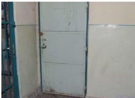
az ingatlanhoz tartozó tároló bejárata (pincszint)
