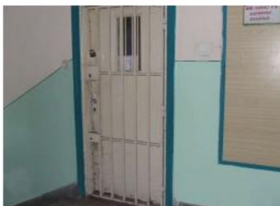
az értékelt ingatlan bejárata
